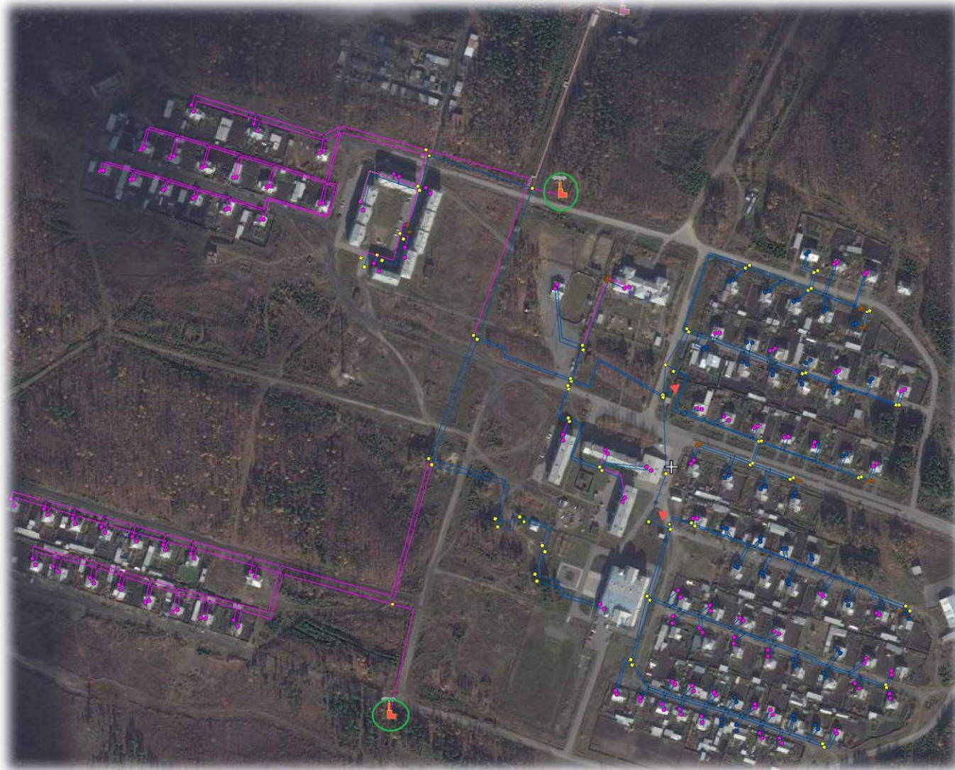
Рисунок 7.1. Реконструкция и прокладка новых тепловых сетей.
